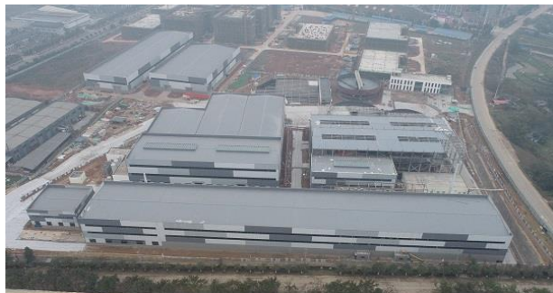
90万吨/年锂矿石精选项目工地
